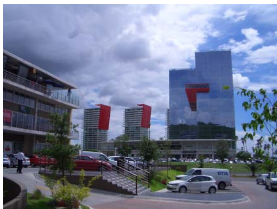
新会社入居予定の事務所外観
