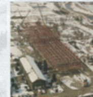
1982年 日本マグファン 敦賀工場建設
