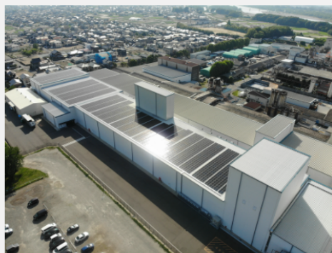
犬山工場の屋上に設置された1,608枚の太陽光パネル 発電出力は495kW
