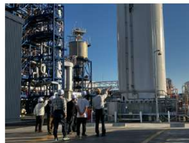
自家火力発電所の見学の様子
