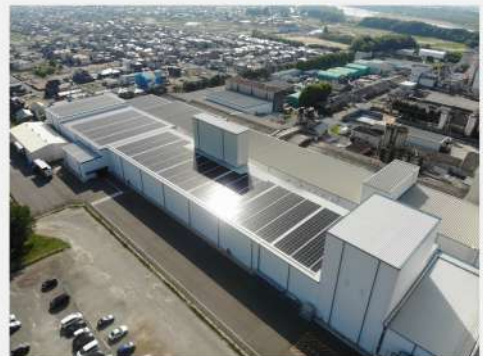
犬山工場の屋上に設置された太陽光パネル 発電出力は 495kW
