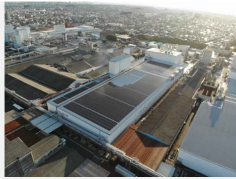
2024年度に犬山工場の屋上に設置された太陽光パネル（定格出力：900kW）
