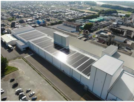
2022年度に犬山工場の屋上に設置された太陽光パネル（定格出力：495kW）
