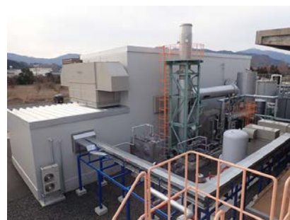
敦賀事業所 ガスコージェネレーション設備
