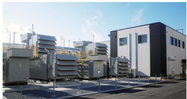
日本エクスラン工業(株)のガスコージェネレーション設備
