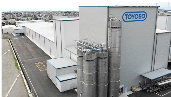
犬山工場に新設した製造設備
