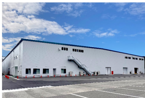
新設した生産設備の外観
